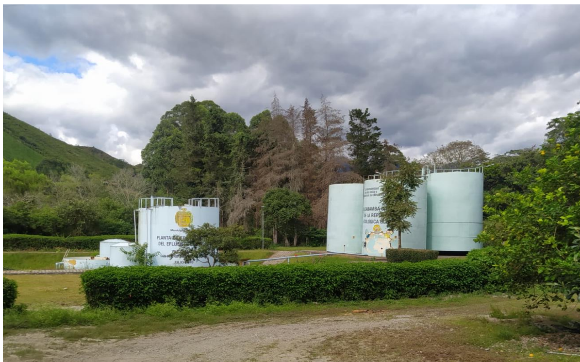
Imagen 3. Planta de tratamiento de aguas residuales Vilcabamba.
